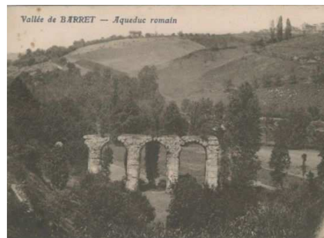
Aqueduc du Gier CCVG
