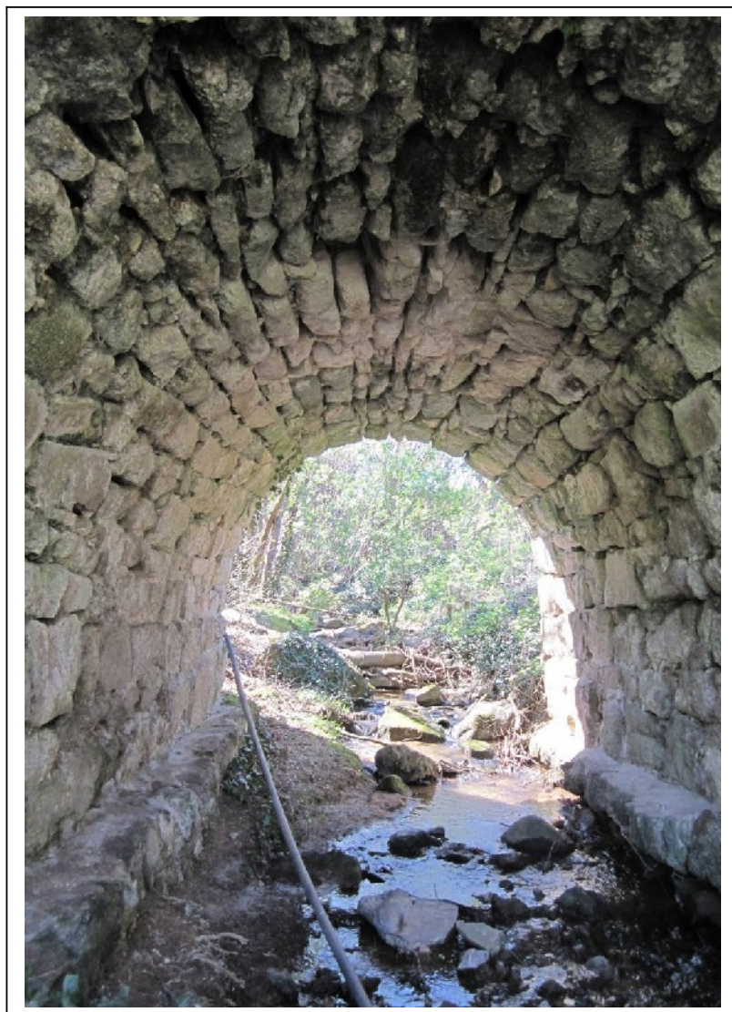
Exemple d'un pont sur le Garon (commune de Rontalon ) très favorable au chauves-souris avec de nombreux dis jointements
